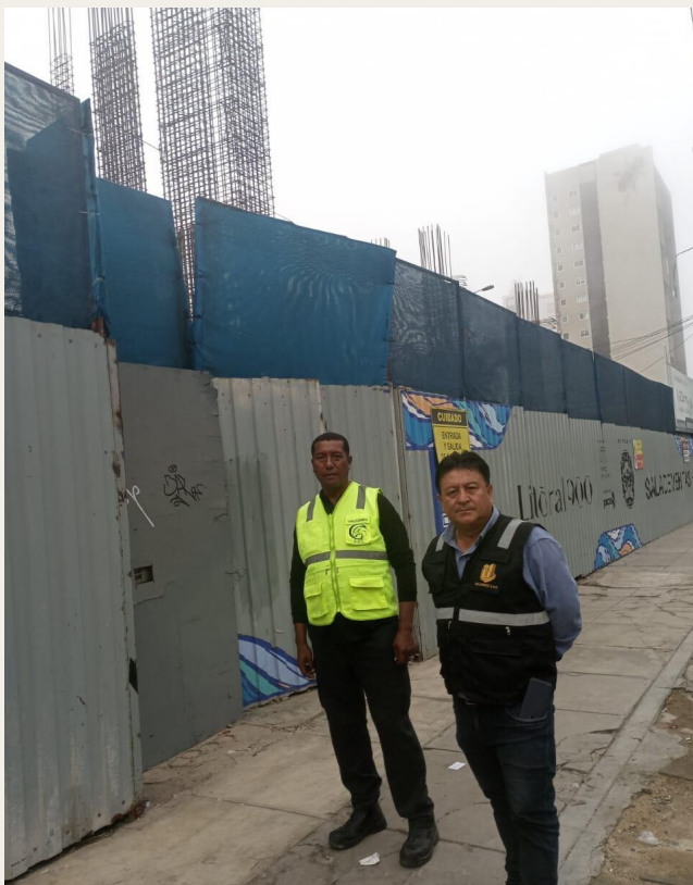
PERSONAL EN EL ACCESO A OBRA
